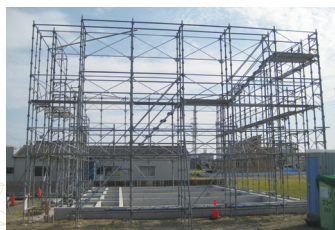
戸建住宅新築工事用足場
