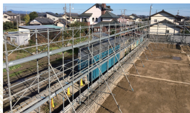
倉庫新築工事用足場
