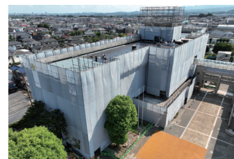
市営住宅大規模改修工事用足場
